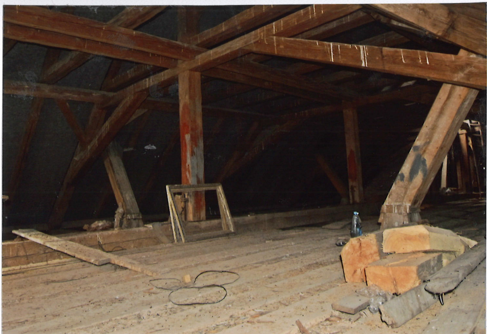
Fot. 12. Więźba dachowa, 2020.
